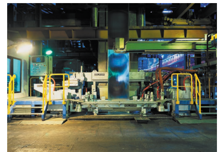
Verzinkungsanlage, U.S. Steel Košice
