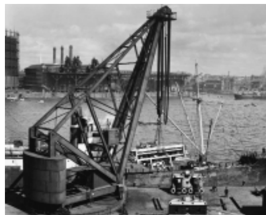
150 t-Kran am Kranhöft
