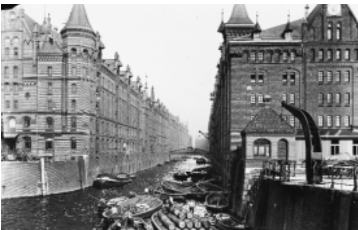
Die neuen Speicher am Kehrwieperfleet
