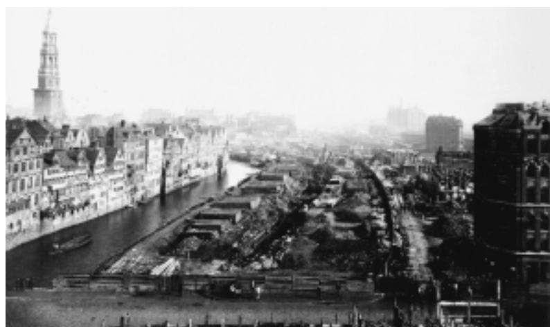
Abbrucharbeiten für die Speicherstadt (1885)
