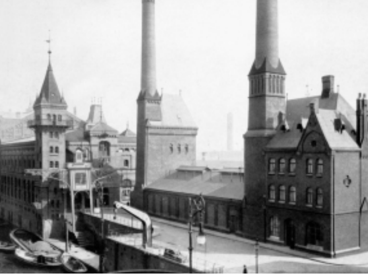
Das „Kesselhaus“, die einstige Centralstation in der Speicherstadt, heute „HafenCity InfoCenter“
