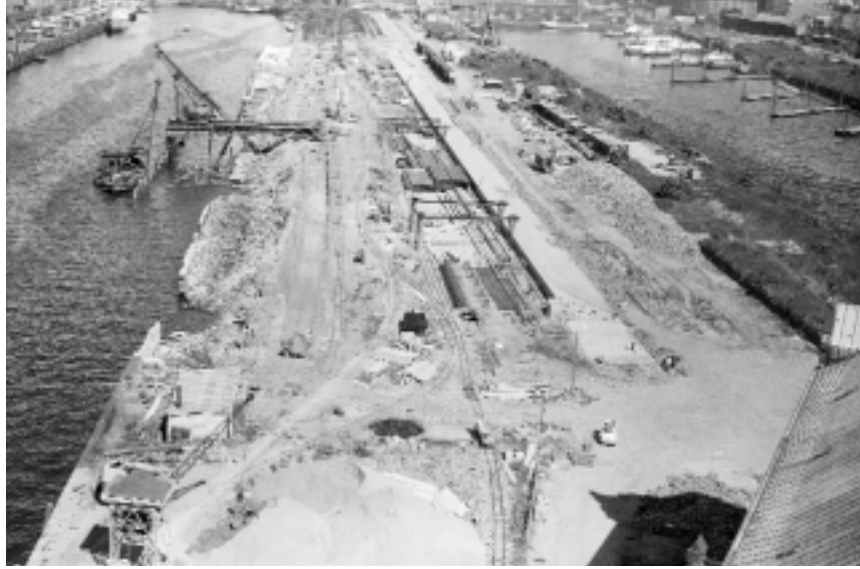
Zerstörung der Schuppen und Kaianlagen, Beginn des Wiederaufbaus
