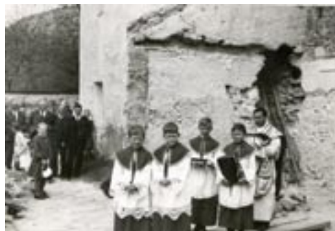
Abbruch der Sakristei 10. Mai 1964 Foto: Archiv Anton Webhofer
