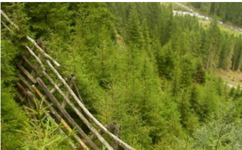
Im Jahre 1991 errichtete Lawinenschutzbauten
