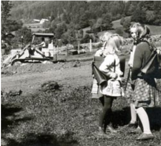
Beginn des Schulhausbaues Mai 1967 in der „Egger Schütte“
