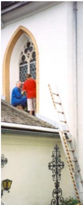
„Kirchenrenovierung“ 10. Mai 2004 Paul und Michl beim Fensterstreichen Foto: Archiv Freimann
