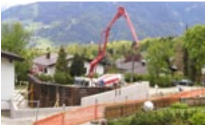
die Wände entstehen
