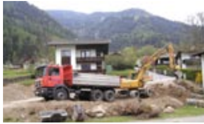
die Bagger kommen
