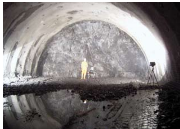
Profilaufnahme mit Tunnelscanner
