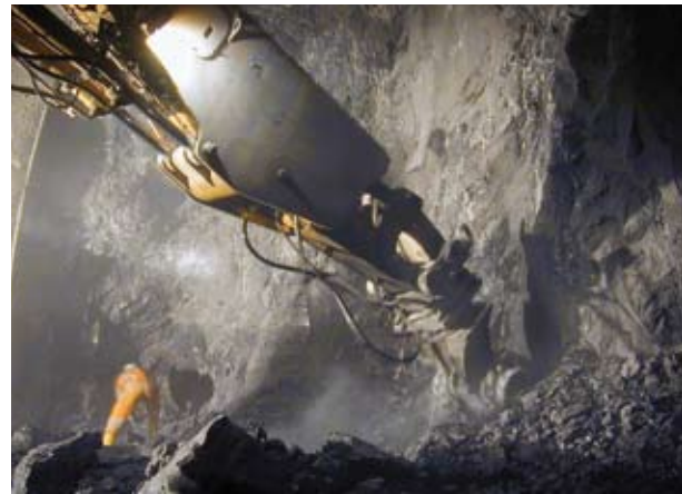
Räumen der Ortsbrust Tunnelbagger mit Teilschnittfräse
