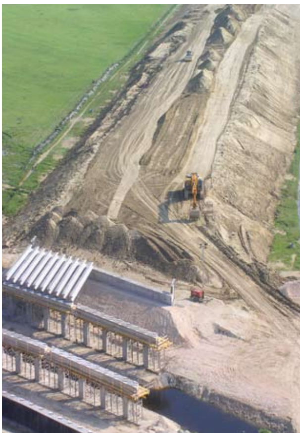
Bau einer (typischen) Fertigteiltrücke
