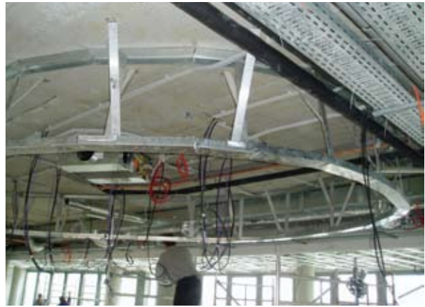
Unterkonstruktion für gekrümmte Glaswände
