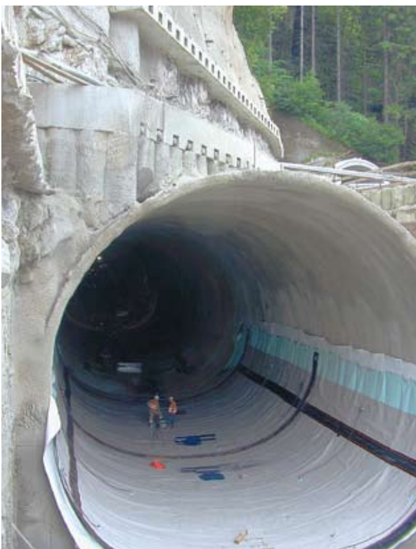
Portal des Tunnels in der Baugrube-Ost im Rohbau
