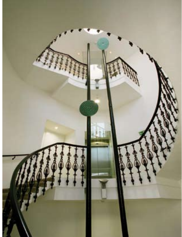
Stiegenhausbeleuchtung mit Reflektoren
