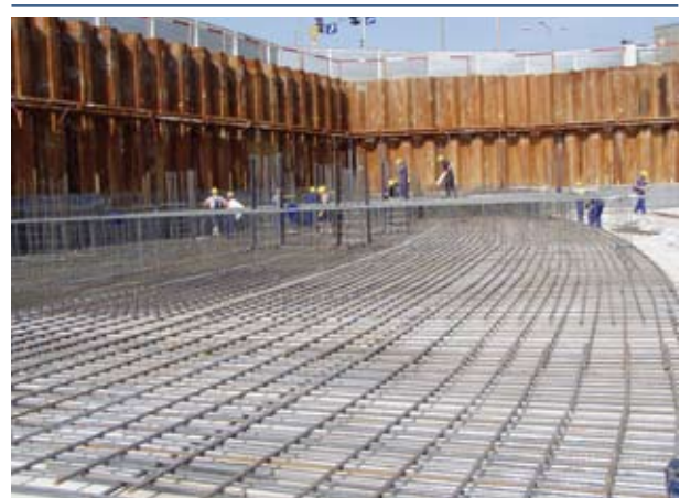
Bewehrung der Fundamentplatte – Juni 2005
