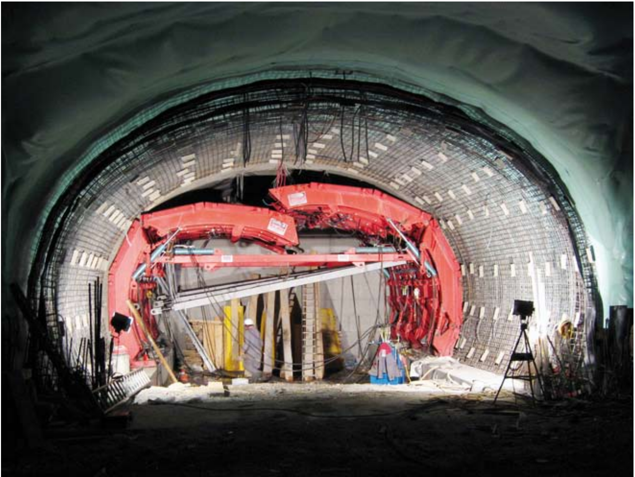
Sonderschalung für Trafonischen etc.
