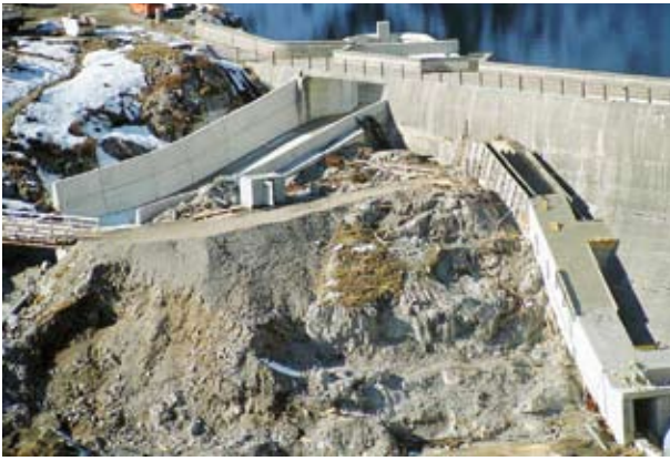
Betonarbeiten – Erhöhung der Leitwände des Entlastungsgerinnes
