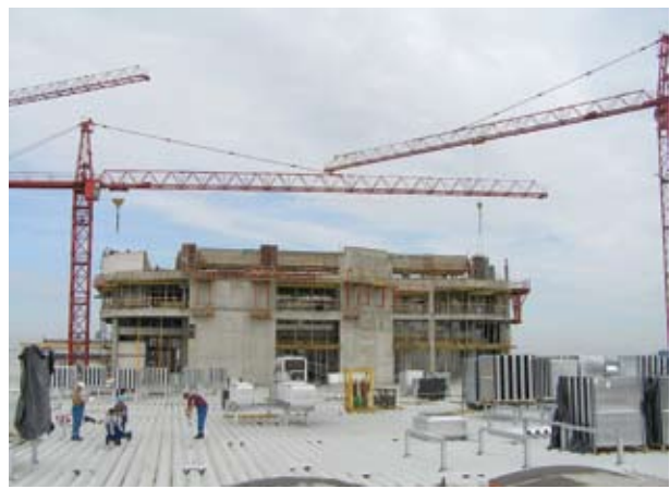
Ansicht vom Dach
