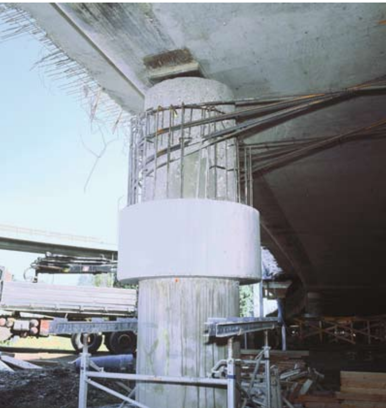
Säulenverstärkung für querfeste Führungslager
