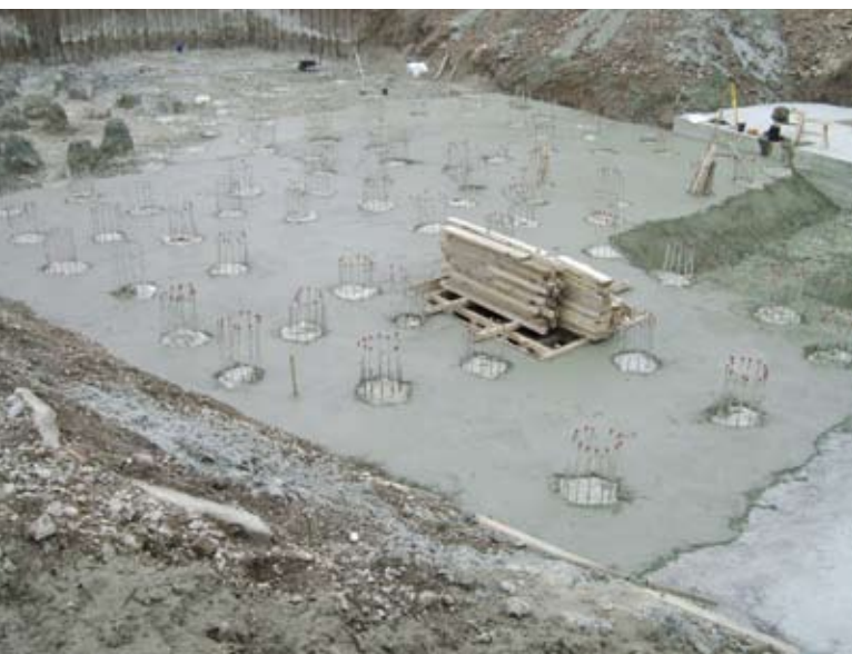
Bohrpfähle und Sauberekeitsschicht
