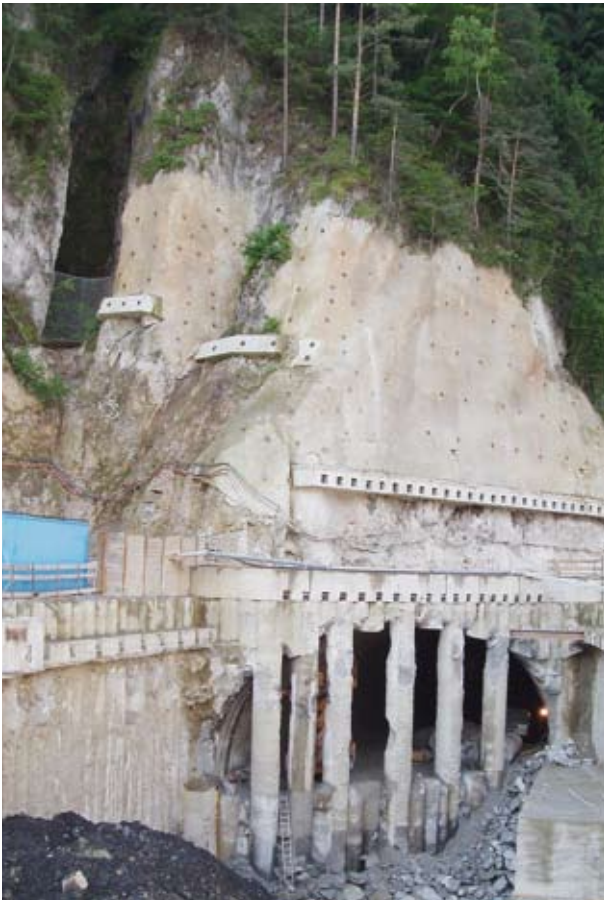
Durchschlag Portal Ost durch die Bohrpfähle
