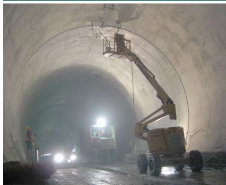
Blockhinterlegungsarbeiten im Haupttunnel
