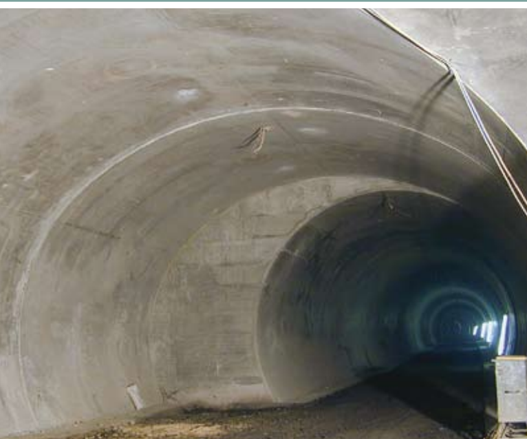
Rettungsstollen Ost mit Ausweichnis 10, fertig betoniert
