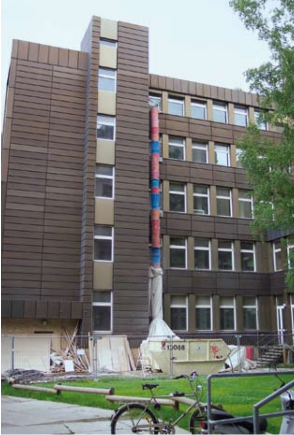
Zustand der Fassade vor der Rekonstruktion
