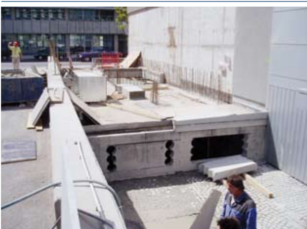
Bewehrungsanschlüsse an das bestehende Objekt
