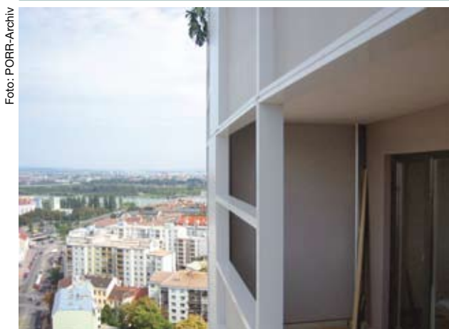
Gridkonstruktion mit Lochblechfüllung als Loggienabschluss
