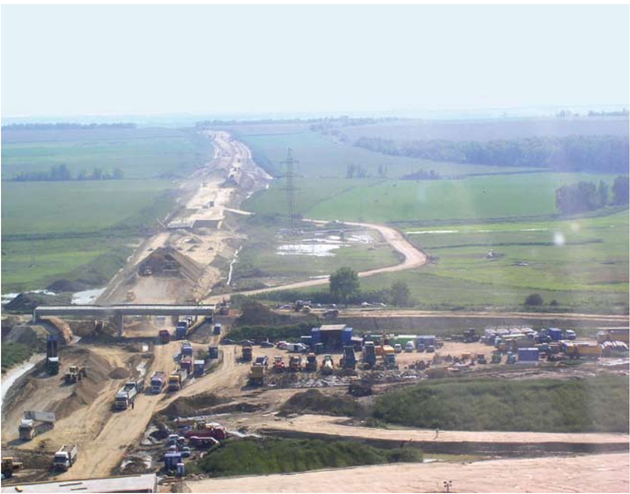
Massierter Erdbaugeräteinsatz im Bereich Querstraße Baulos 2
