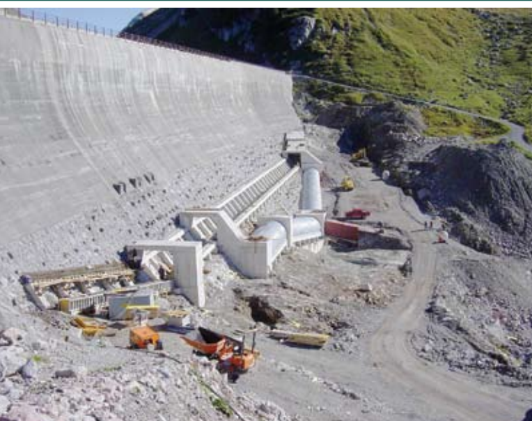
Südsperre – Bau der Drainage- und Zugangsstollen inklusive Verbindungsbauwerke
