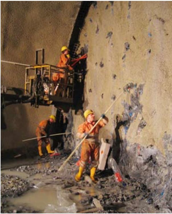
Laden der Ortsbrust mit Sprengstoff
