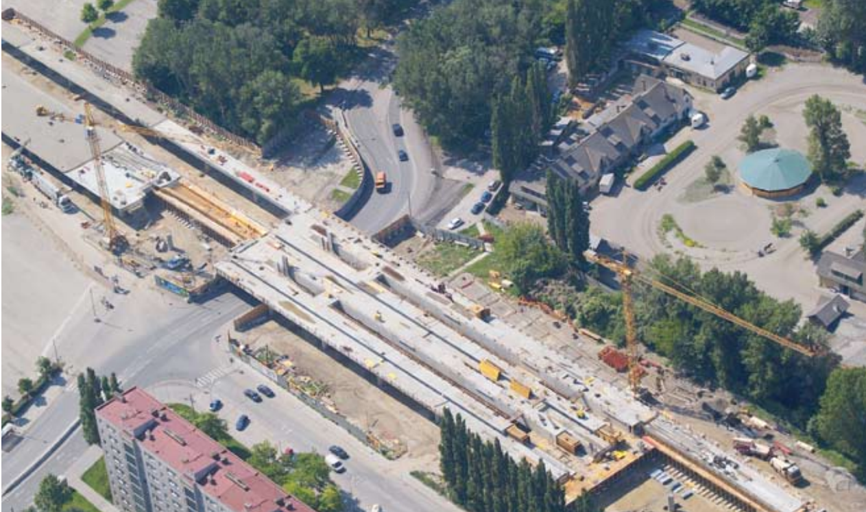
Strecke in Hochlage – Tragwerksherstellung Ecke Meiereistraße/Vorgartenstraße
