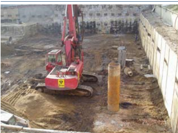
Bohrpfahlarbeiten
