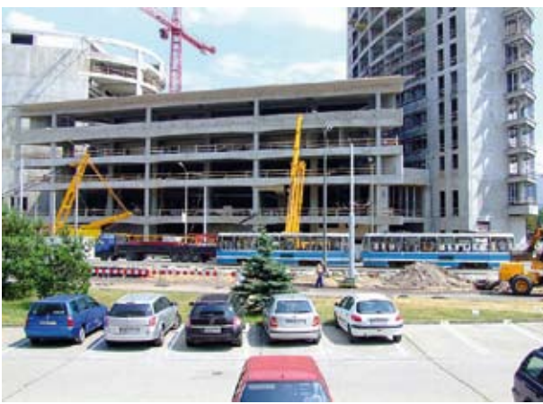
Kinosäle im Rohbau
