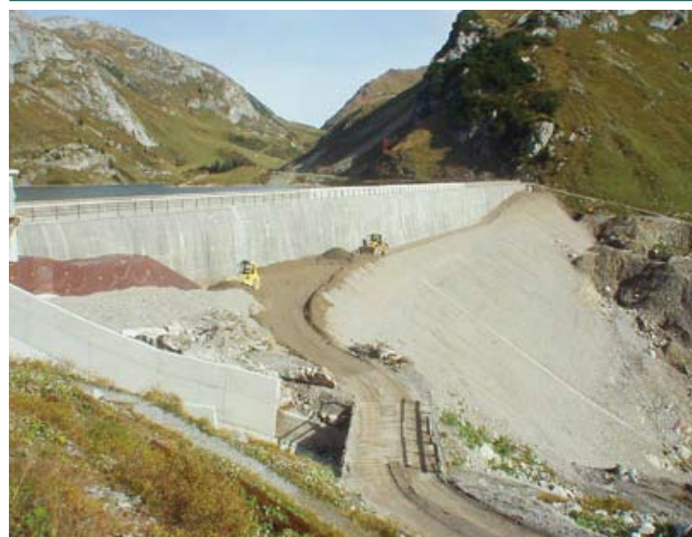
Aufschüttung der Südsperre vor Endfertigstellung 2005
