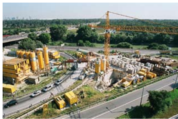
Baustelleneinrichtung Tunnelbau am Autobahnknoten A 23 Südosttangente Wien / A 4 Ostautobahn
