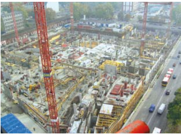
Übersicht der Baustelle vom Turmdrehkran aus – Oktober 2005
