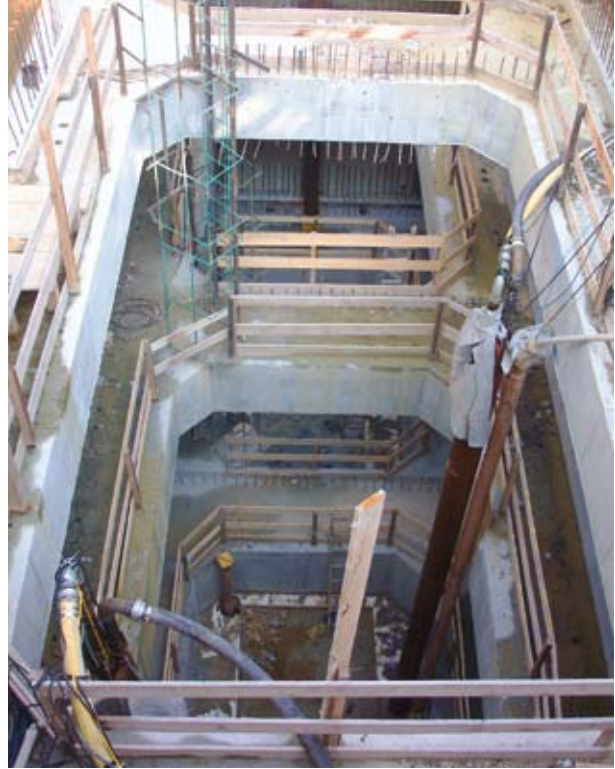
Notausstiegsschächte mit Aussteifungsrosten
