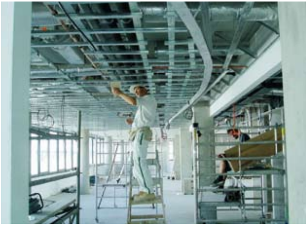
Herstellung der Gipskarton-Deckenunterkonstruktion
