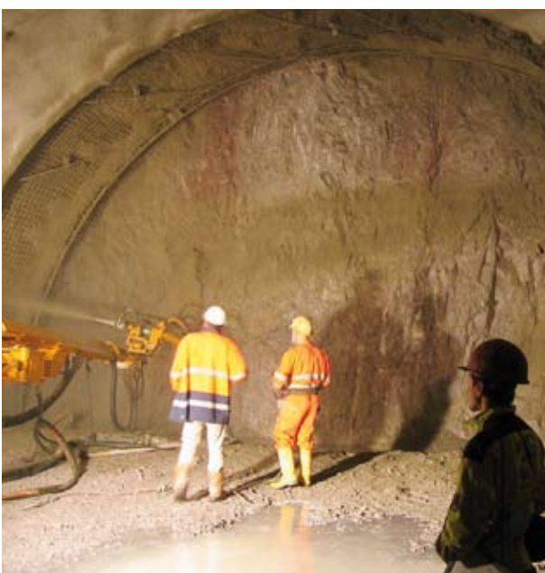
Auftrag Spritzbeton im Haupttunnel
