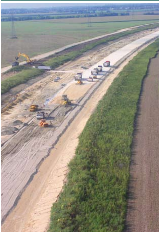
Frostschutzzeinbau Baulos 1
