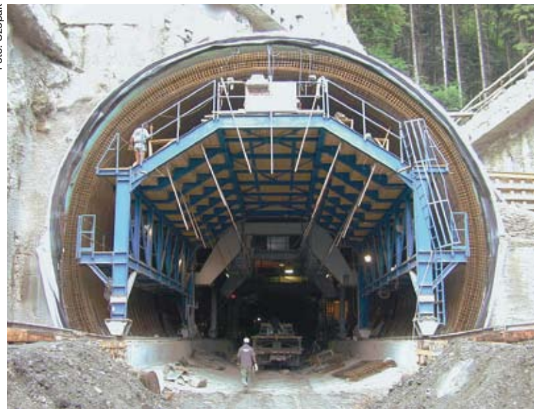
Der Bewehrungswagen beim Ostportal
