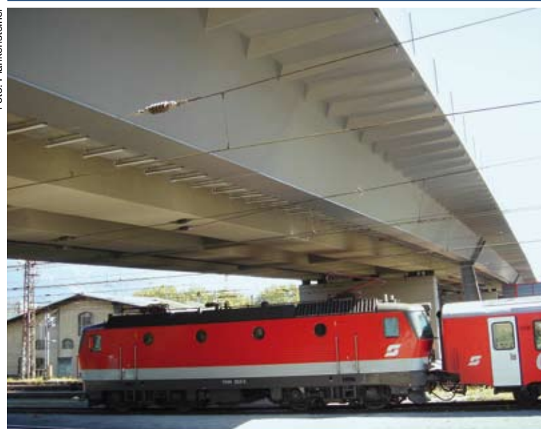
Untersicht Hohlkastenkonstruktion – Stahltragwerk
