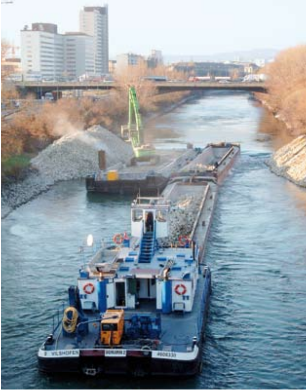
Ballastschüttung Donaukanal
