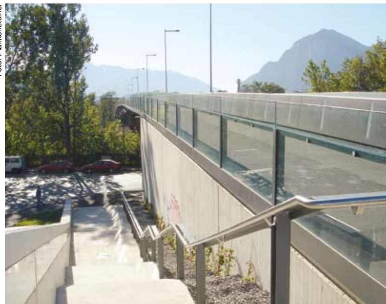
Ansicht Stiegenabgang Ost und transparente Glasbrüstung
