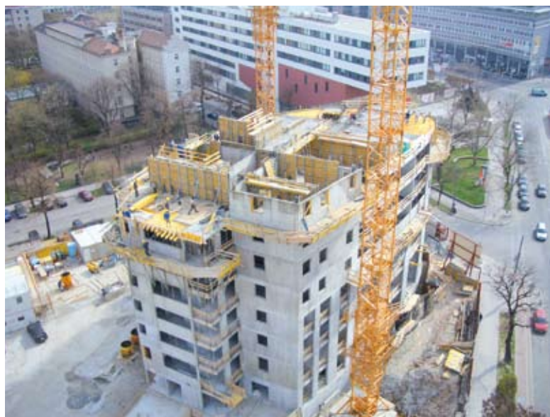
Rohbau Ortbeton
