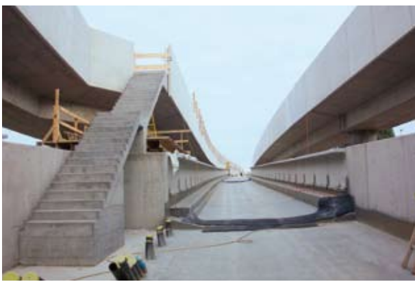
Übergangsbereich Hochstrecke – Betriebsgleis
