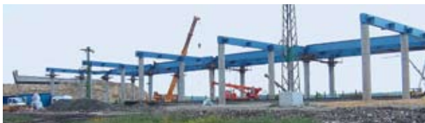
Verschiedene Brückentragwerke: Fertigteilträger, Wellblechdurchlass und Stahlverbundbrücke
