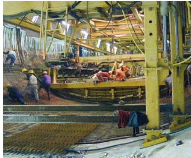
Sohlgewölbeschalwagen und Einbau der Sohlbewehrung
