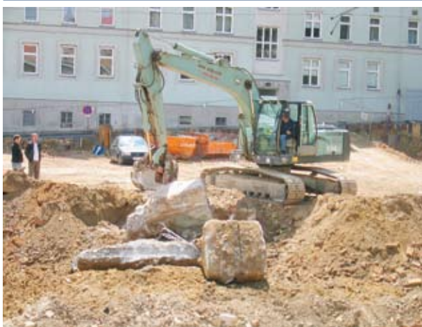
Sachverständige beobachten und beurteilen den Aushub im Bereich der nachgewiesenen Kontamination
