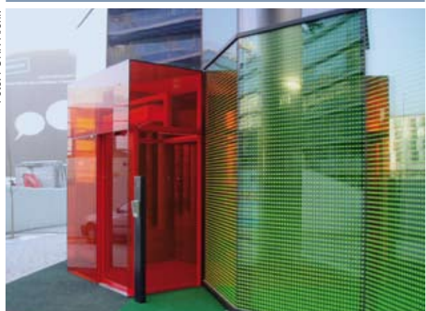
Haupteingang „Rote Box“
