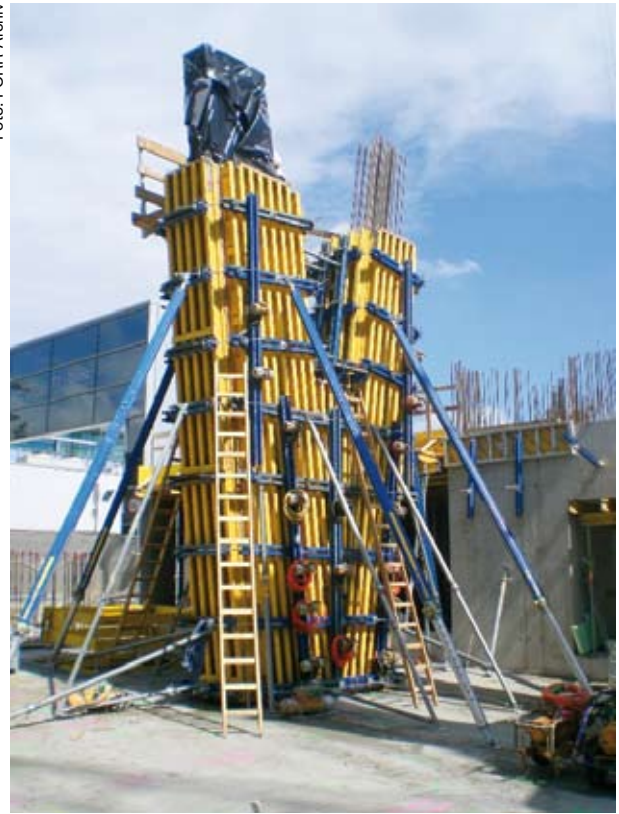
Schalung der V-Stützen
