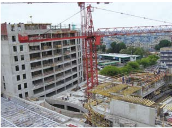
Ansicht auf Bürogebäude von Südost
