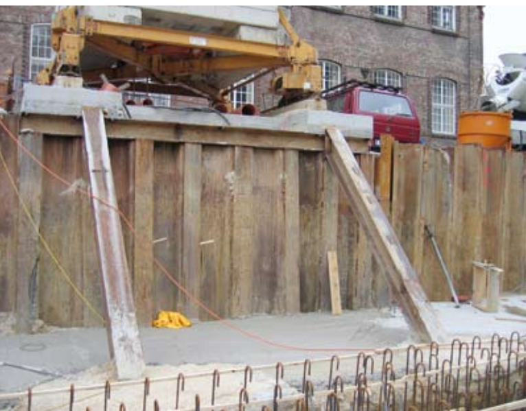
Kranfundament mit Baugrubensicherung
