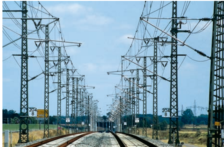
418 Kilometer Oberleitungsanlagen wurden im Projekt neu errichtet.
