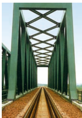
Mittellandkanal bei Oebisfelde: Länge 108 Meter
