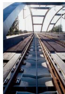
Havelkanal bei Wustermark: 86 Meter lange Stabbogenbrücke
