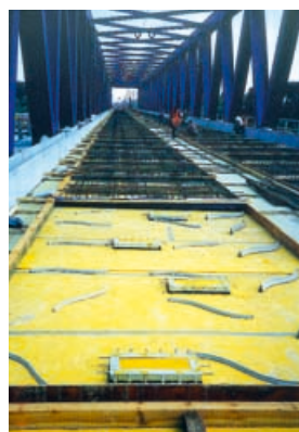
Havel bei Rathenow: Länge 230 Meter
