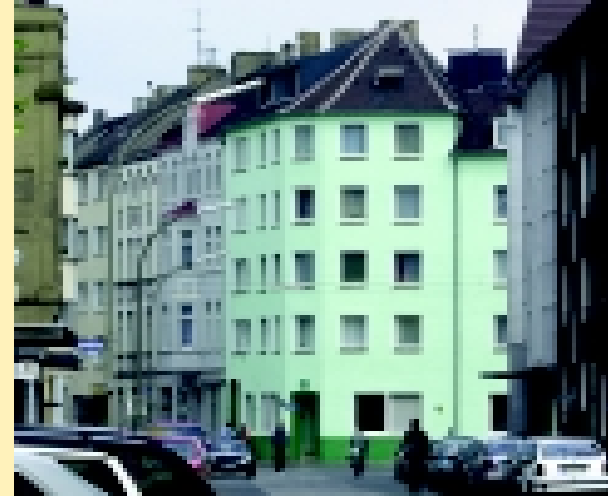
Außenansicht des Gebäudes, in dem sich im Erdgeschoss die Moschee befindet
