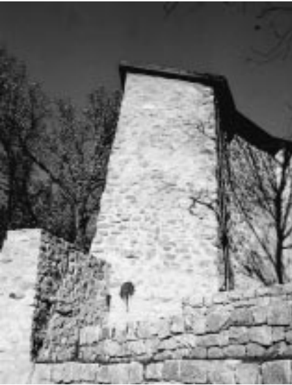
Detail der mächtigen Maueranlagen nach der Sanierung.
