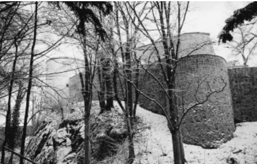
Ansicht einer vom Verfall bedrohten und nun sanierten Ringmauer.
