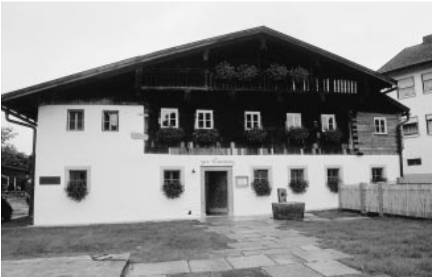
Das renovierte Emerenz-Meier-Haus ist nun der markante Mittelpunkt des schönen Dorfes Schiefweg
