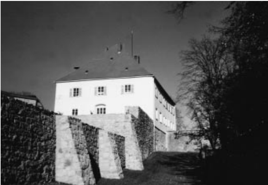
Hauptgebäude und innere Ringmauer nach der Sanierung.
