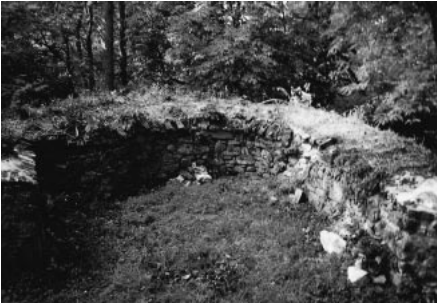
Imposant sind die nun wieder sichtbaren Wehranlagen.
