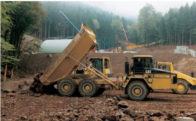
Abb. 14: Dumper mit einer Nutzlast von 23 t fahren über die spätere Autobahntrasse zum Dammbau
