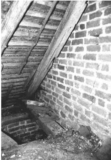
Abbildung 2: Schwellbalkenkonstruktion des 15. Jahrhunderts im Apsisdach.
