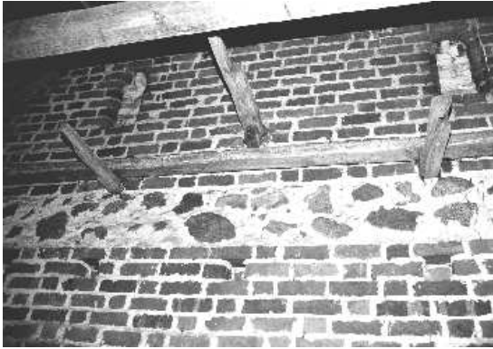
Abbildung 1: Eingemauerte Ankerhölzer des mittelalterlichen Dachstuhls.
