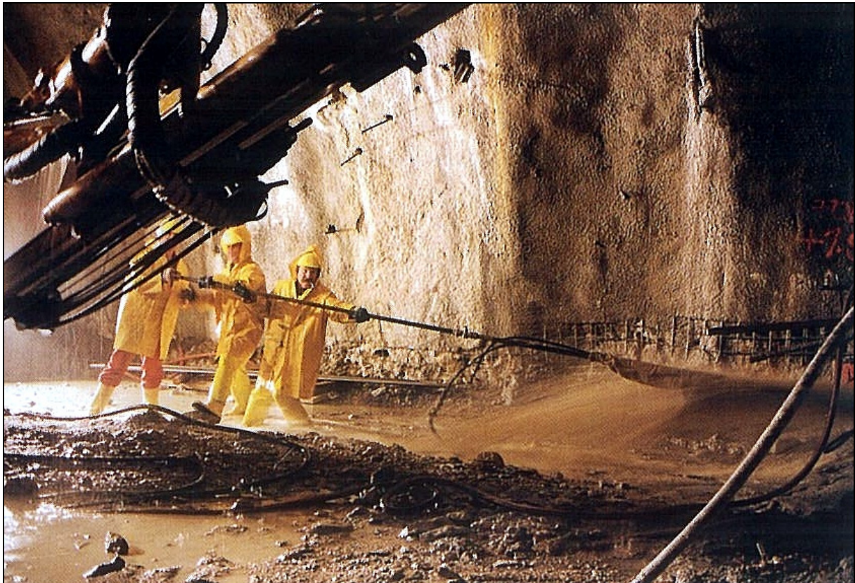
Abb. 7: Das Einschieben eines Injektionspackers gegen einen Wasserdruck von 3 bar stellte höchste Anforderungen an Mannschaft und Gerät.
