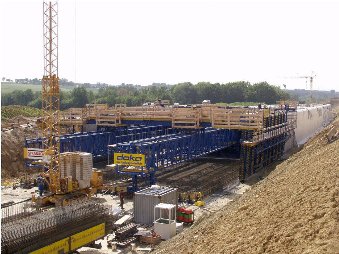
Abb. 7: Hier war die Bodenplatte schon bewehrt und der Vorfahrträger bereits vorgefahren, so dass auch die Außenschalung vorgefahren werden konnte. Für den Verfahrvorgang wurde das bewährte Prinzip des Kletterantriebs der Selbstkletterschalung aus der Vertikalen hier in die Horizontale übertragen.>
