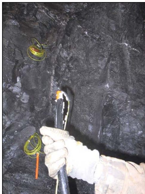
Abb. 3: Lötschberg Basistunnel Baulos Mitholz Ladevorgang (Foto Lehner)
