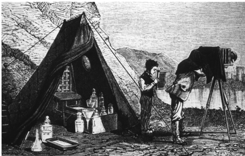
Abb.5: Ausrüstungszubehör des Reisephographen mit Dunkelkammerzelt, um 1865. Im Dunkelzelt mussten die Platten unmittelbar vor der Aufnahme präpariert und sofort danach entwickelt werden.
