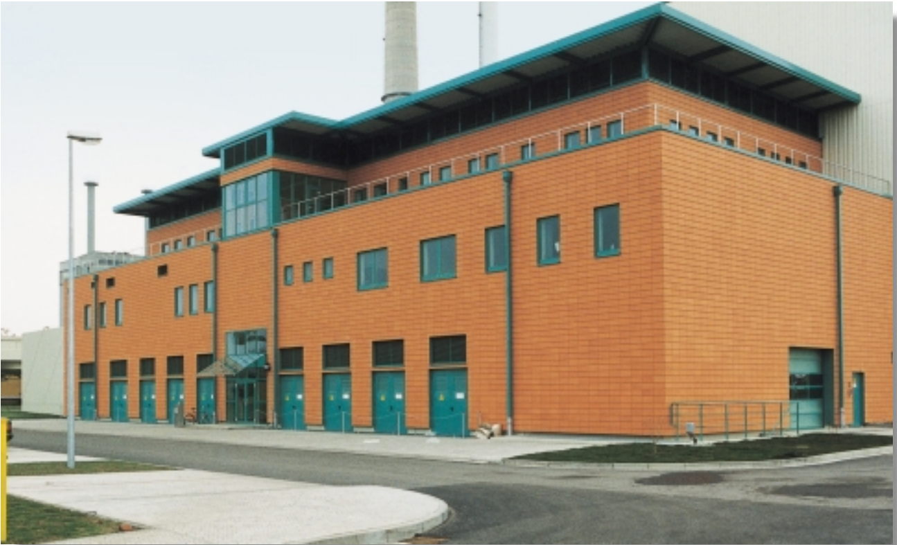
Rückansicht Energieerzeugungsanlage Erfurt-Ost
