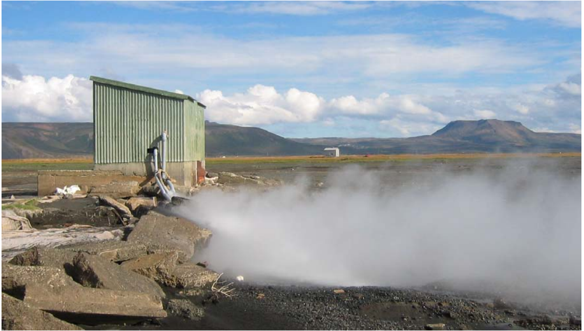
36. mynd: Borhola ÆR-03 í Skógalóni hefur aðeins verið nýtt að fjórðungi í hitaveitu.
