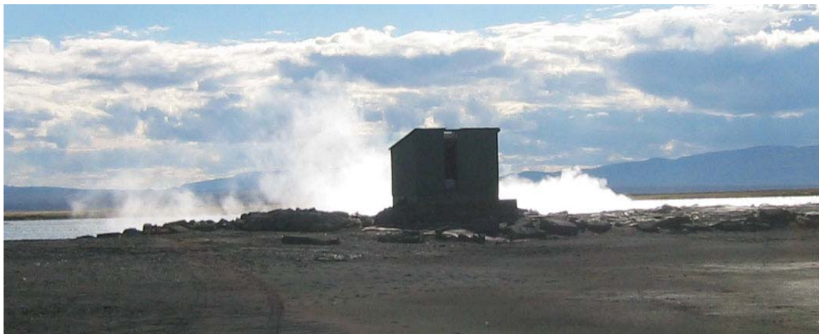
9. mynd: Borhola ÆR-03 í Skógalónum. Sú hola er nýtt til hitaveitu.
